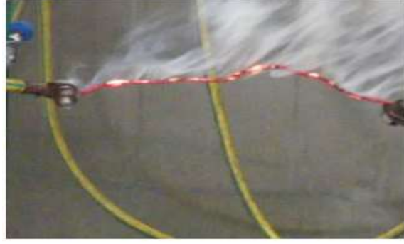
Resim 1. Aşırı akımda çekilen kablo yangını
