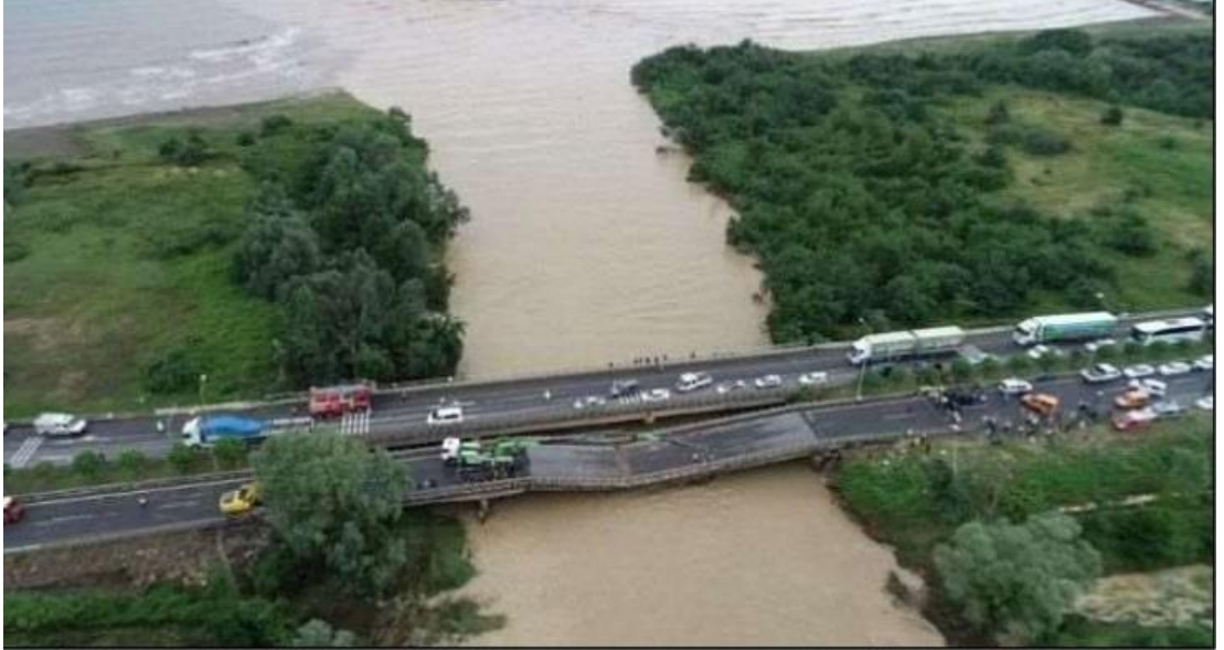
Şekil 2.9. 8 Ağustos 2018 tarihinde meydana gelen sel olayı sonucu Karadeniz Sahil Yolu üzerinde yıkılan Ünye Cevizdere Köprüsü [37]
